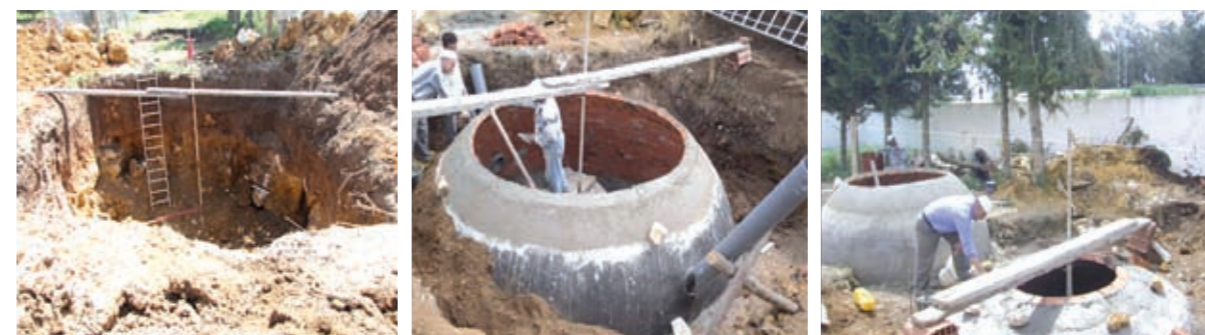
Travaux d'implantation d'unité de fermentation anaérobie sise l'école primaire ouedi béja
