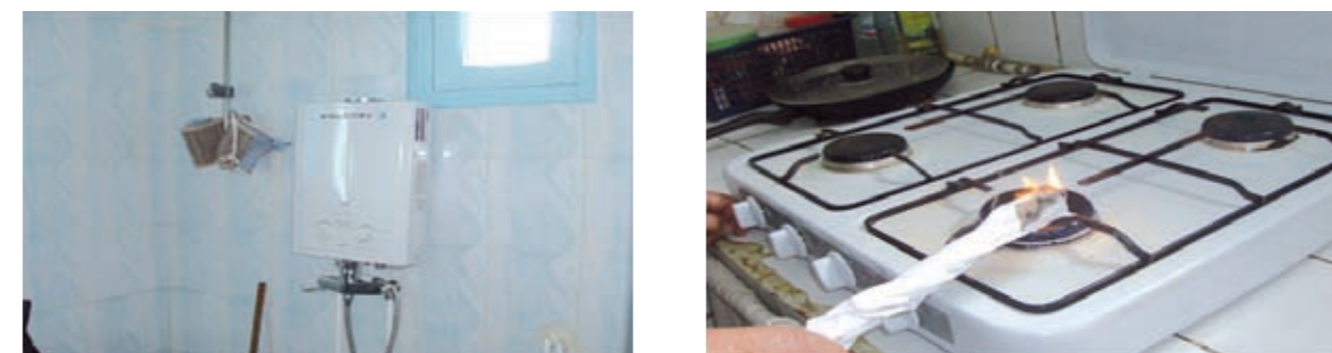
Equipements de valorisation de biogaz produit par l'unité de valorisation de déchets organiques
