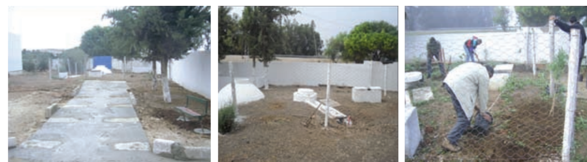
Travaux d'aménagement autour de l'unité de fermentation anaérobie sise l'école durable ouedi béja
