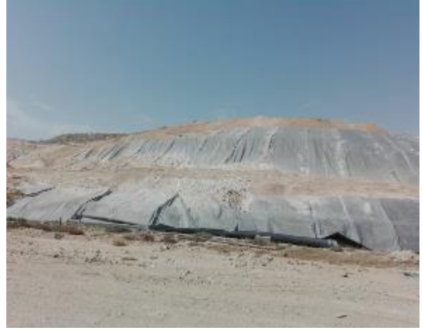
1 أشغال تهيئة شبكة الغازات بالمصب المراقب بقابس
